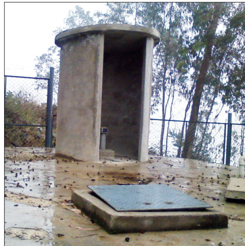
Foto 2. Caseta sin equipo de cloración en Huachupampa
