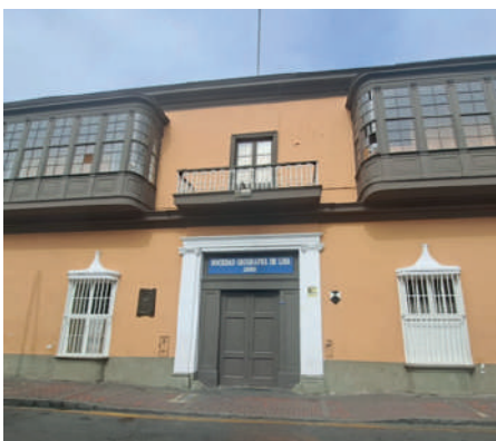
Fachada de la Sede de la Sociedad Geográfica de Lima. Cuenta con elementos arquitectónicos del neoclásico. Portada con pilastras jónicas, balcón de cajón abierto con rejería de hierro, dos balcones de cajón cerrados y cinco ventanas de reja con peana y coronela. (Archivo PROLIMA. Ficha y plano catastral)
