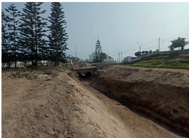
Figura 5. Puente que obstruyó el flujo de detritos el 14 y 15 de marzo de 2023
