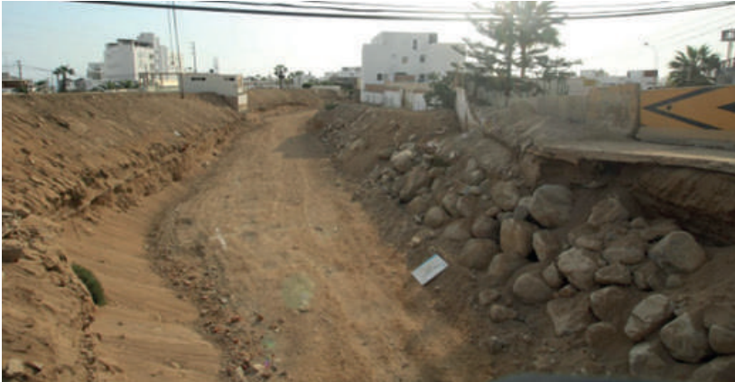
Figura 8. Ampliación del cauce aguas debajo de la carretera Panamericana
